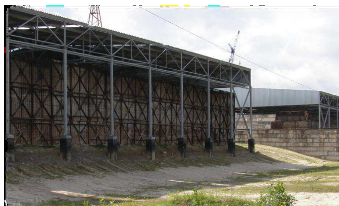
Figure 5 : Vue du site d'entreposage de Podlesny
