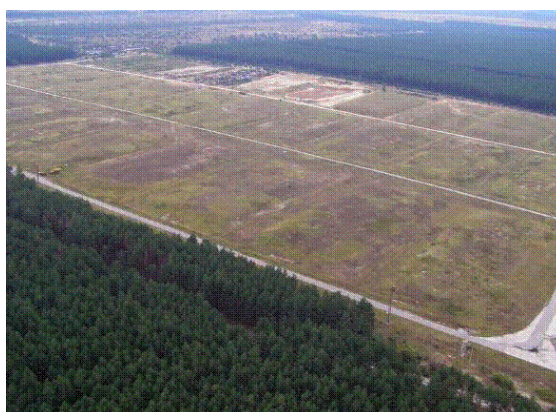
Figure 4 : Vue du site de stockage de Buriakovka
